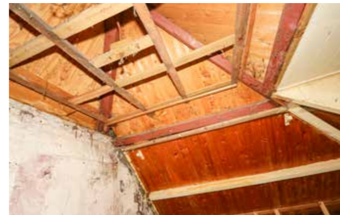
dakbeschoot zolder boven opkamer
