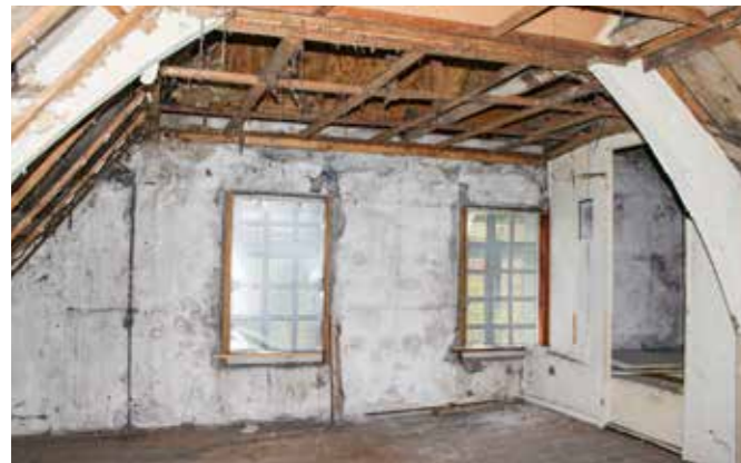
voorste zolder aan westzijde
