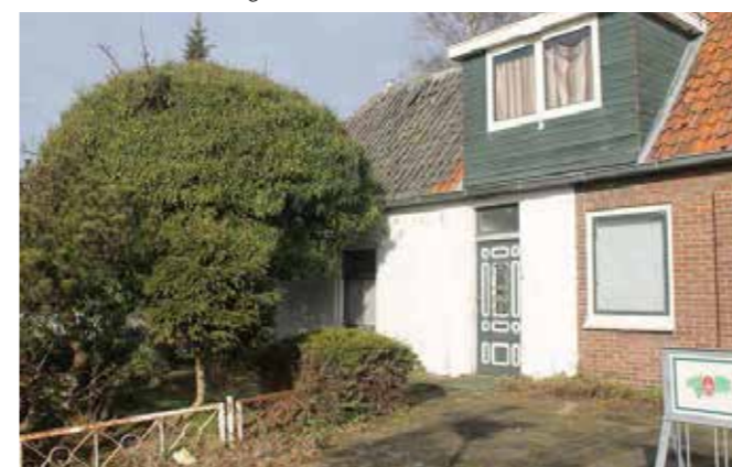
2016 linker deel zuidgevel met voordeur (foto uit Van Geest/van Es 2016)
