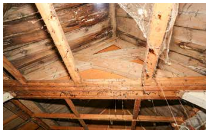
detail verlegde nok Philiberspant
