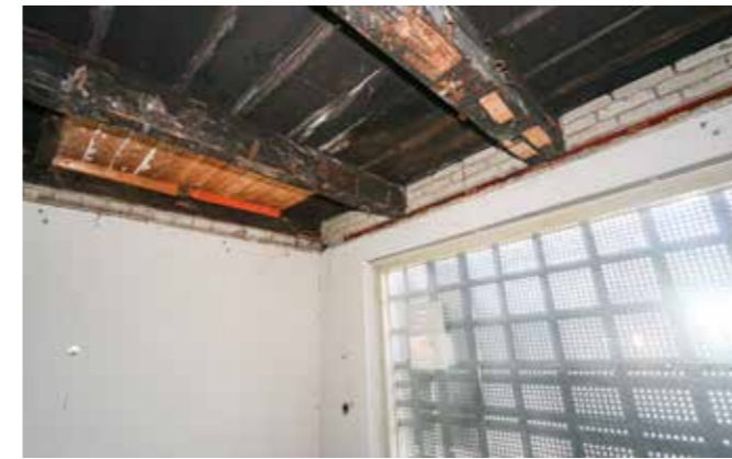
balklaag bij de winkelruit in de zuidgevel
