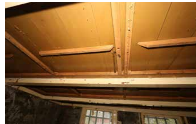
balklaag en planken linker voorkamer
