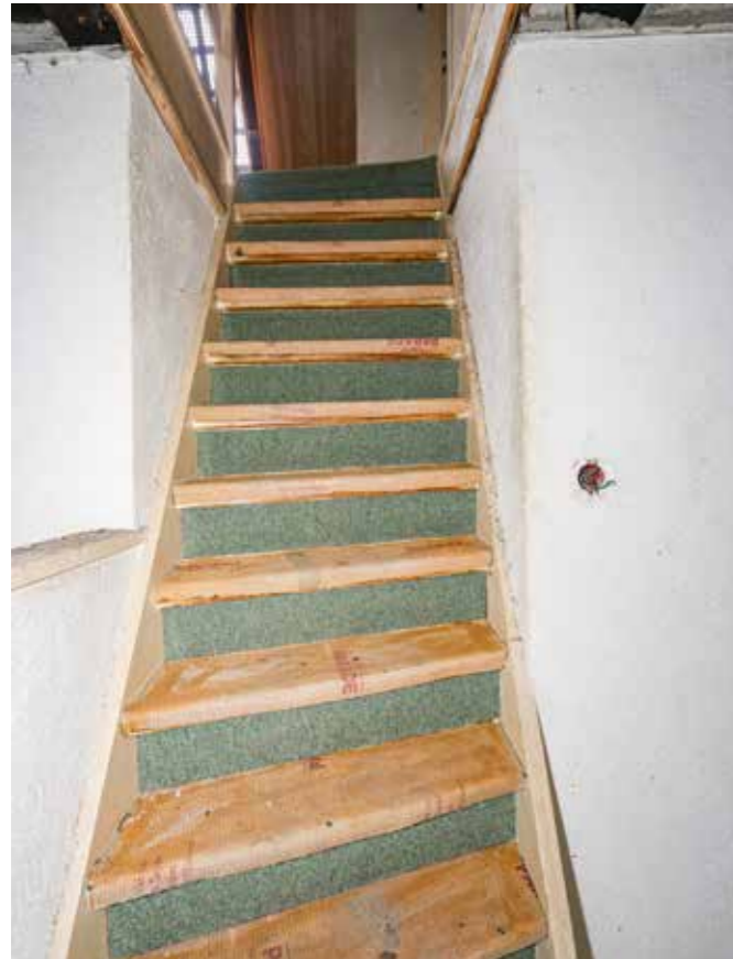
trap naar zolder in dwarsgang
