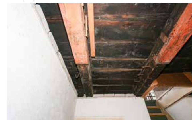
balklaag in dwarsgang
