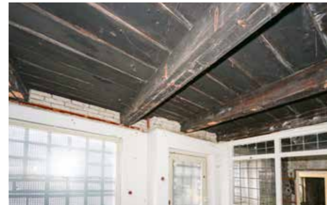
balklaag bij ingang winkelruimte
