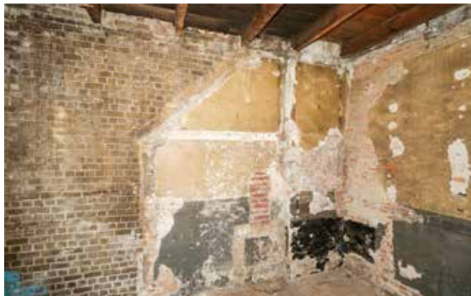
aftekening gesloopte aanbouw met lessenaardak (0.6)
