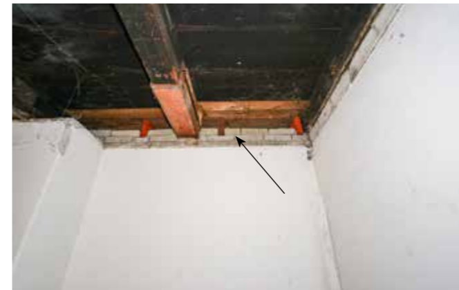
wand tussen 0.4 en 0.5, bij de pijl kalkzandsteen en balkkoppen 0.5
