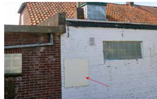
dichtgezet vulluik kolenopslag in noordgevel
