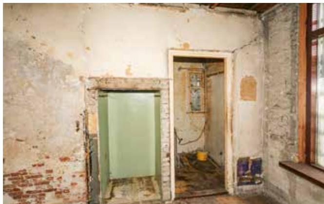
schouw met rechts bijruimte (0.7) met trap naar de kelder
