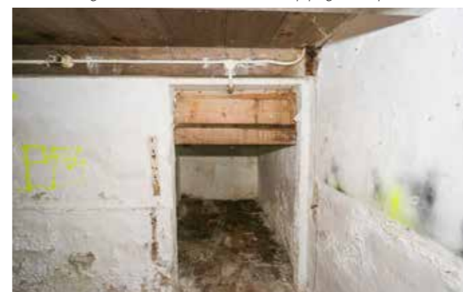
voorraadhok in de kelder
