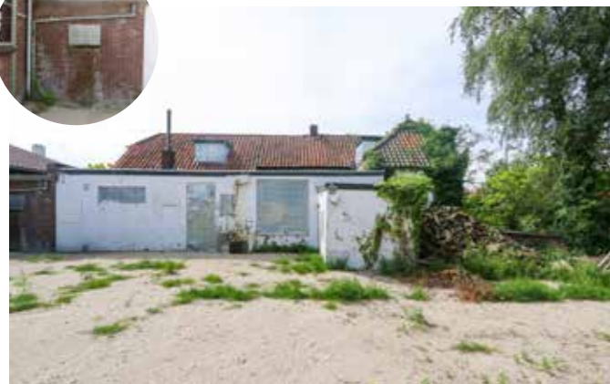
noordgevel, inzet: tussenlid bij werkplaats
