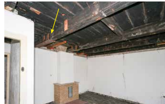
winkelruimte (0.4) met schouw, bij de pijl een stalen slof
