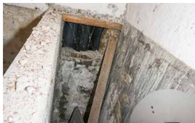
detail kolenopslag met stortluik
