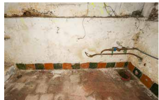
vloer met cementtegels en plint van estriken
